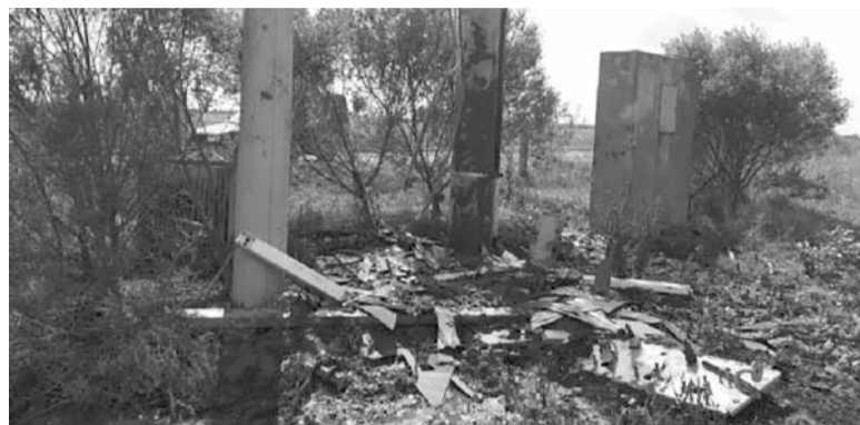
Desolador. Así quedó la planta transmisora. - LT3 -
