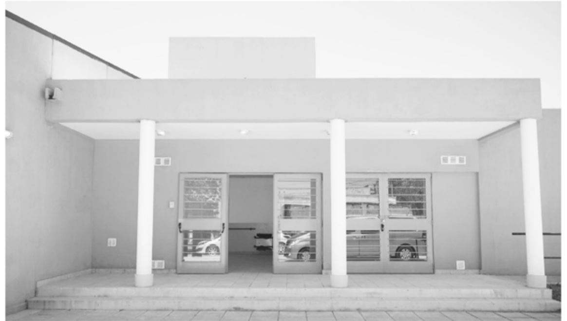
En Bolívar se construyó el nuevo edificio de la Escuela de Educación Especial N° 502.
