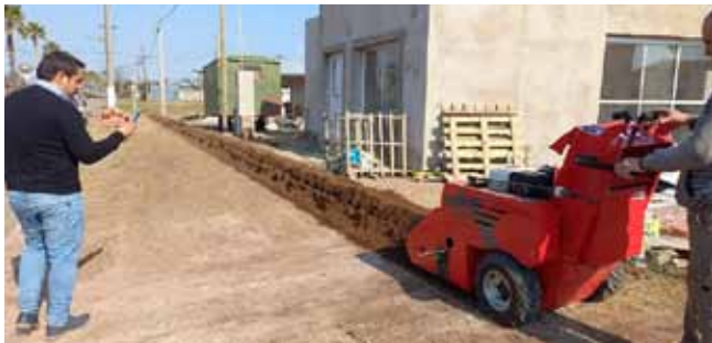
bles subterráneos y fibra óptica.
