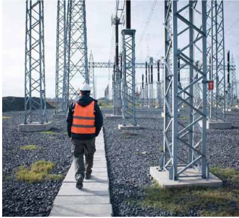
Una obra clave. Para evitar cortes de luz
