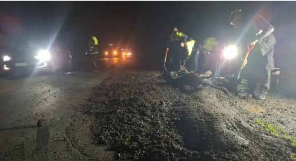
Trabajos en plena noche. Tal como lo informó la gestión municipal, efectivos de Seguridad Vial y Defensa Civil se encargaron de reparar el bache para recuperar la transitabilidad del lugar.
