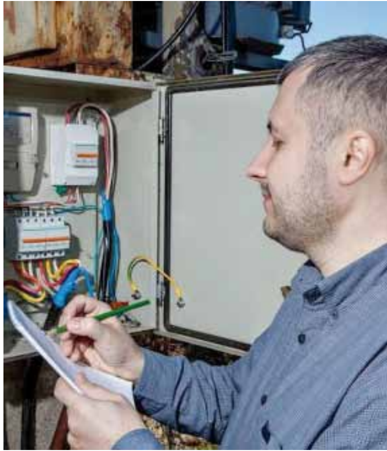
Cautelar. Los consumos de electricidad, en la mira.
