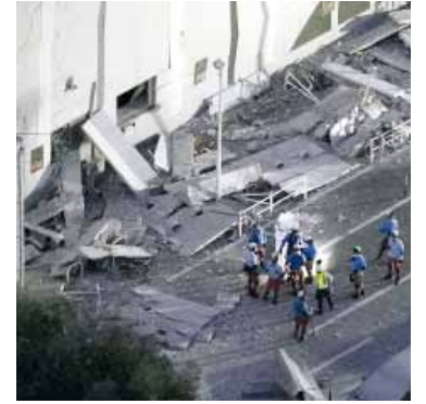
El centro comercial Aeon Mall Kumamoto se desplomó.
